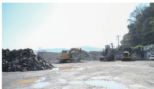
現場の中には、海が目の前の現場も。
